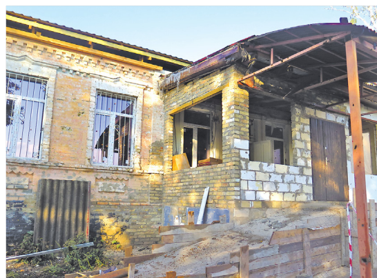
修復工事が進んだ、ホストメリ市立第 1 学校モスティシェン分校の校舎 = 2022 年 9 月 15 日、ウクライナ・ホストメリ市 ©朝日新聞社
